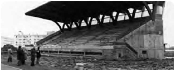
Visite par Jacques-Eberhard du chantier de construction en 1976
