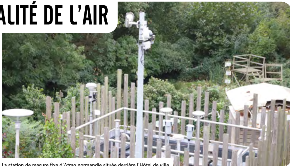
La station de mesure fixe d'Atmo Normandie située derrière l'Hôtel de ville
