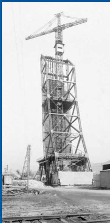
Montage du pont 8
