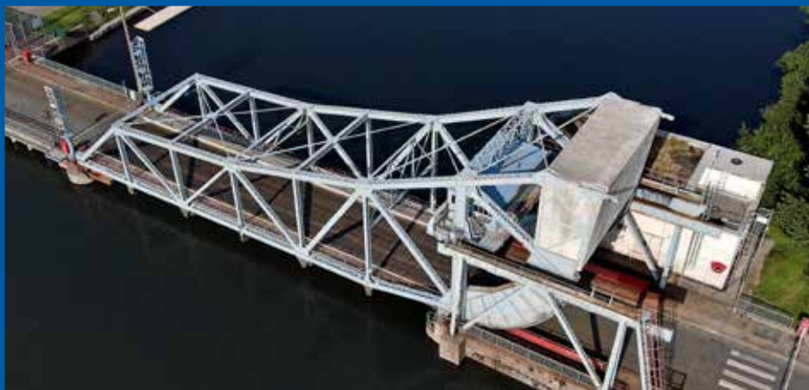
État actuel du pont 8
