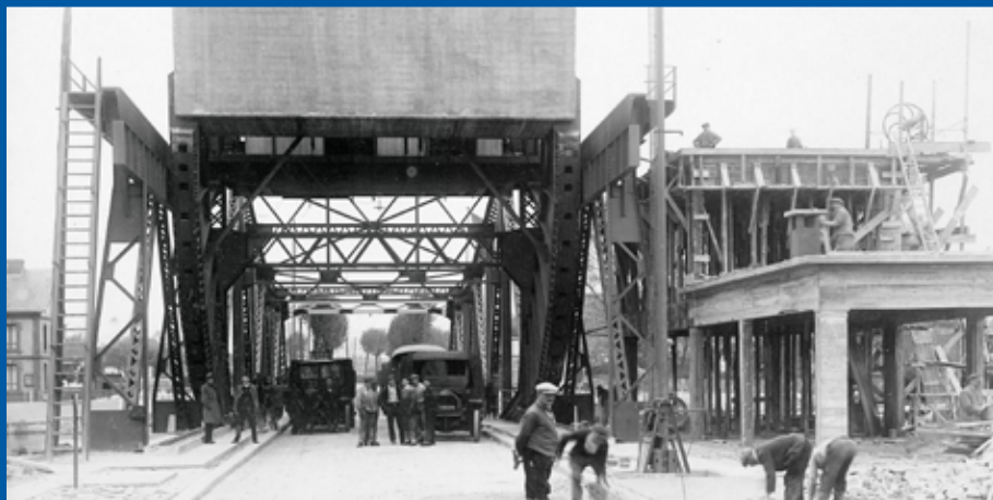
Essai de charge du pont 8
