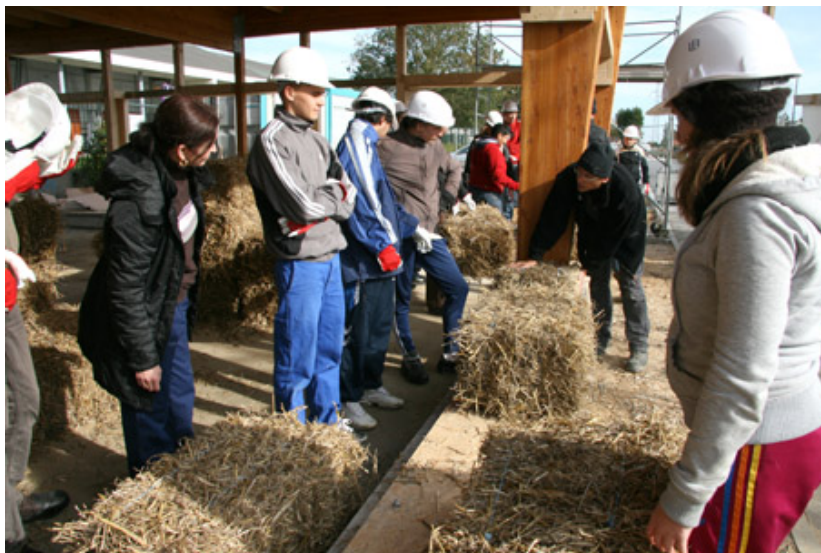
Chantier participatif du local des jeunes Le chantier participatif s'est déroulé du 24 octobre au 2 novembre 2011.
